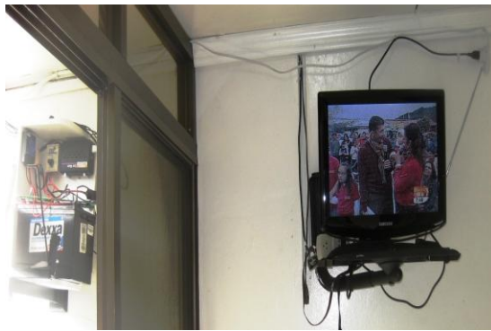
Fig. 8. Uso del Paneles Fotovoltaico en la casa del autor- para alumbrado (12VCD), TV y cargar computadora (110VCA).
