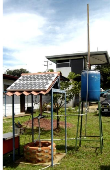
Fig. 6 A (Alumbrado) y 6 B (Bombeo de Agua) instalados fuera de la Casita Solar.
