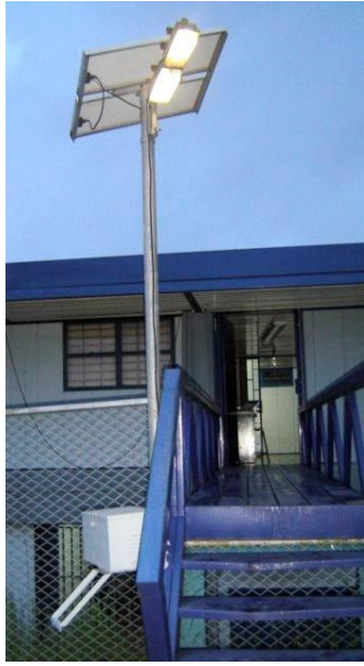
Fig. 6 A (Alumbrado) y 6 B (Bombeo de Agua) instalados fuera de la Casita Solar.
